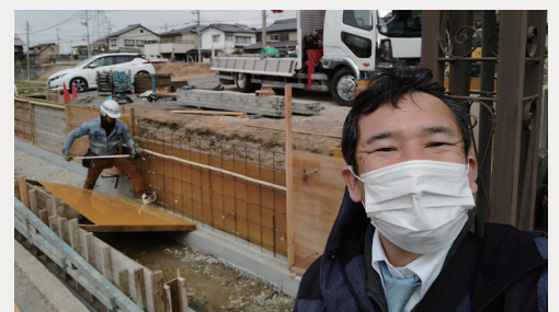
▲かねてから相談を受けていた稲美町の障害者グループホーム。兵庫県の補助を受けて建設中です
