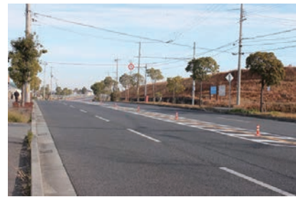
一部4車線となった県道宗佐土山線
